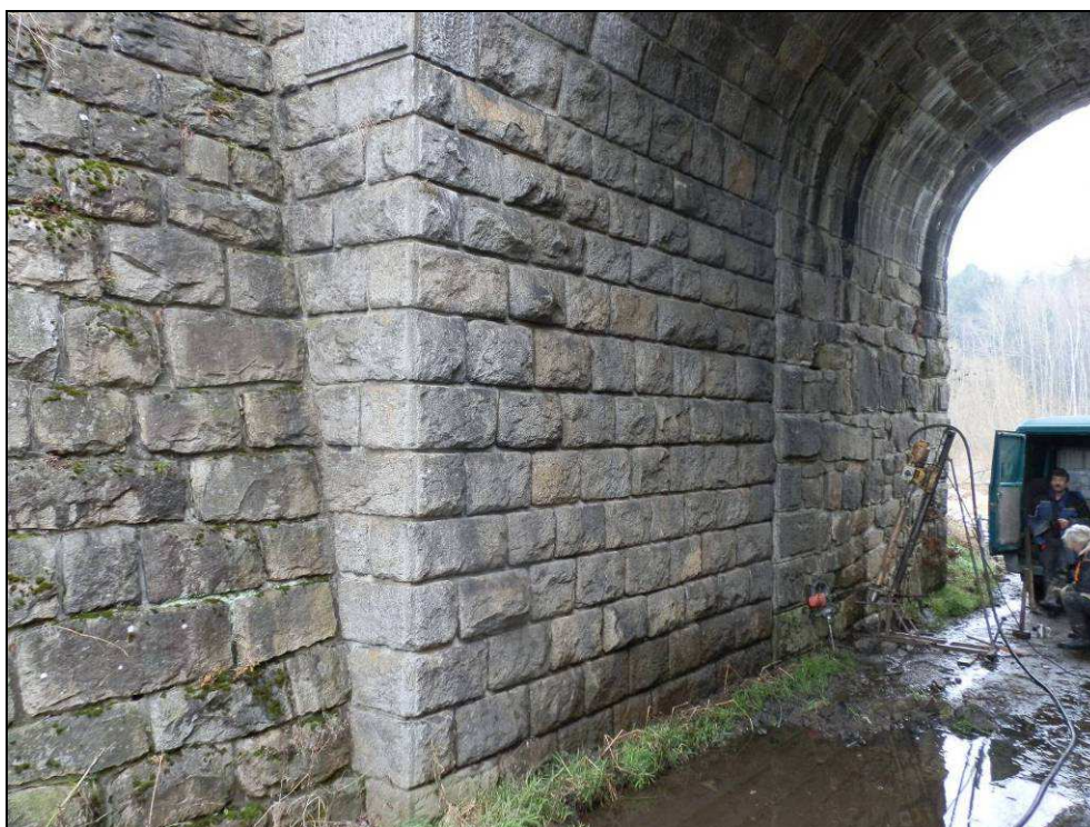
Obr. č. 10 - oprav Nepomuk, pravá (vzdálenější) strana opěry je původní
